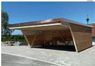
Neubau Carport 8132 Hintereg
