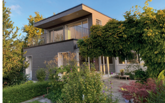
Aufstockung EFH 8708 Männedorf
