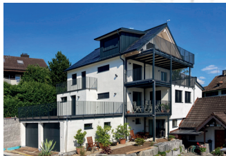
Umbau EFH 8704 Herrliberg
