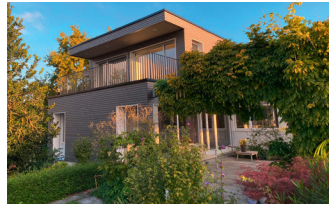
Aufstockung EFH 8708 Männedorf
