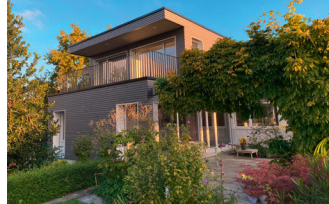
Aufstockung EFH 8708 Männedorf
